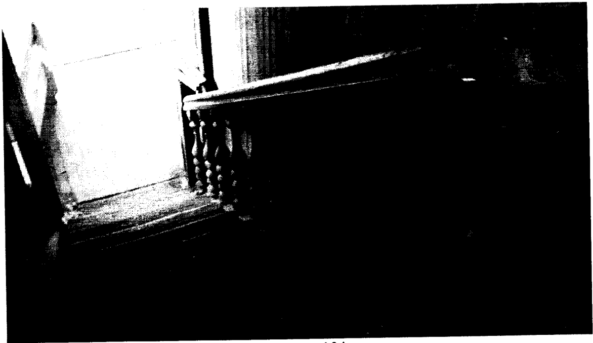
Фото 4 Лестница на второй этаж, Амурская, 104.
